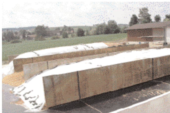
In 4 Silos zu jeweils 800 cbm wird die Maissilage konserviert
